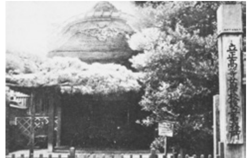
妙法寺境内の立正高等女学校設立事務所
